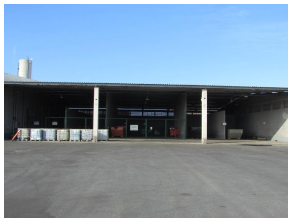
Figura 28: Galpão de Resíduos.
