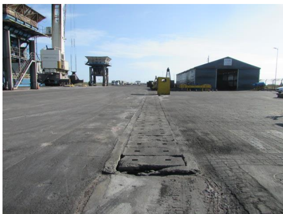
Figura 15: Canaletas tampadas do cais.
