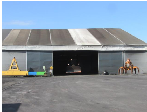
Figura 18: Galpão de fertilizantes no cais.
