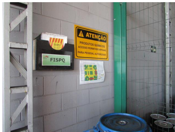
Figura 26: FISPQ e informes de compatibilidade de produtos perigosos no Galpão de Resíduos.
