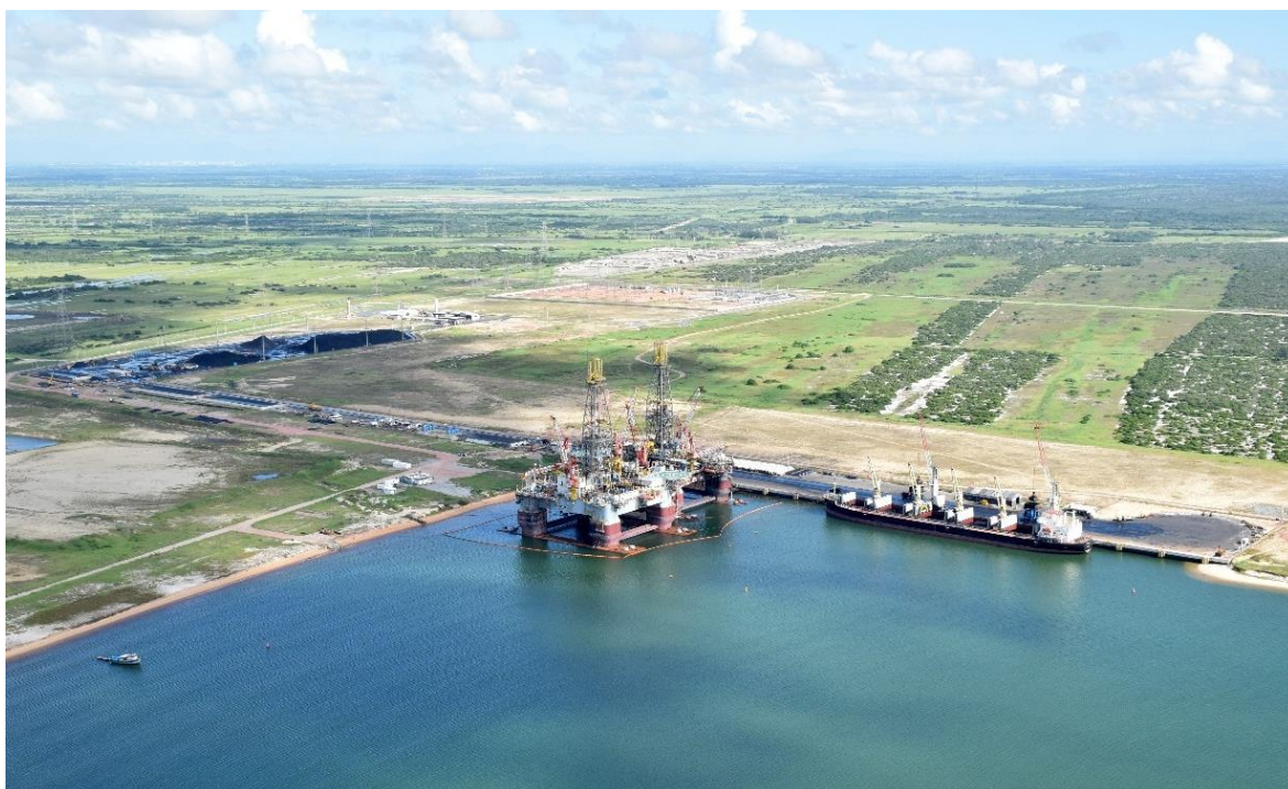
Figura 4-2: Vista do Terminal de Múltiplo Uso (T-MULT), anterior a instalação do Galpão Lonado.
