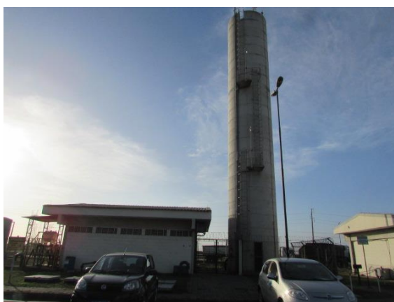
Figura 36: Caixa d'água no escritório administrativo do TMULT.
