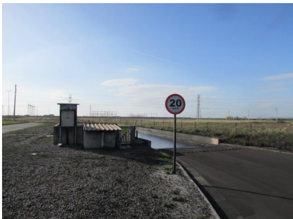
Figura 31: Lavador de rodas e placa de redução de velocidade na Portaria do TMULT.
