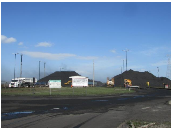
Figura 1: Entrada do Pátio de Granéis.
