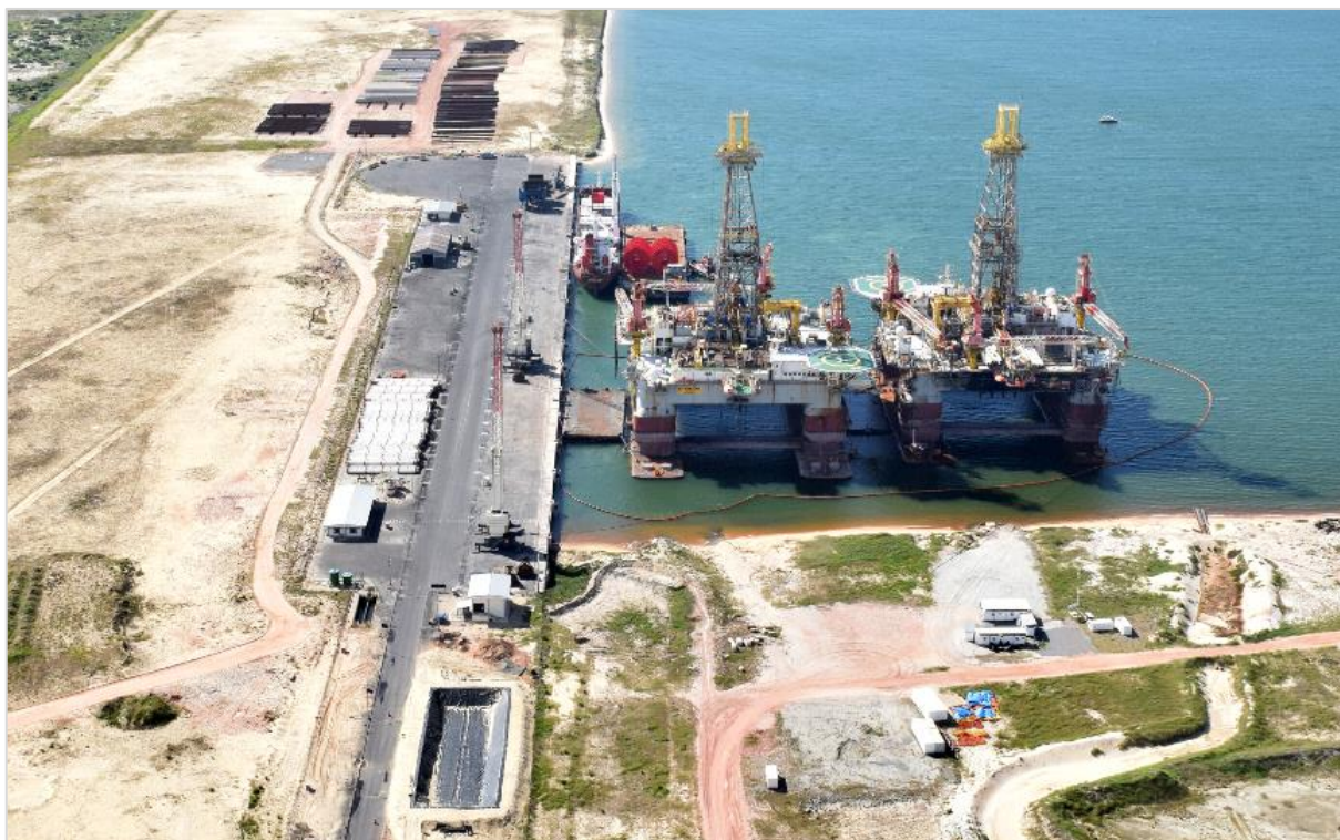
FIGURA 3 – FOTO AÉREA DO CAIS NO ÂNGULO LESTE – OESTE
