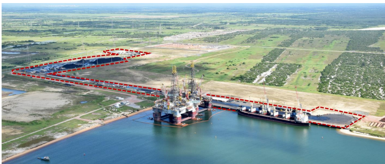
FIGURA 8 – VISTA ÁREA DO T-MULT
