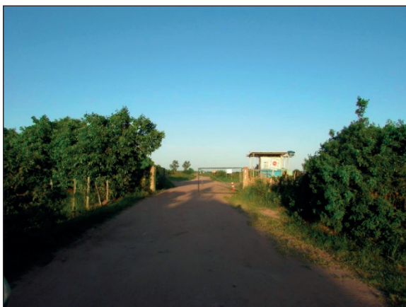
Figura 79: Guarita da entrada principal da RPPN, acesso via Cajueiro
