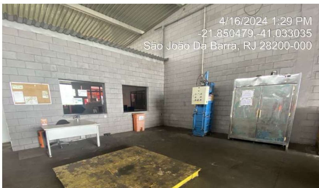
Figura 4-15 – Área de armazenamento de lixo comum e compactador de resíduos
