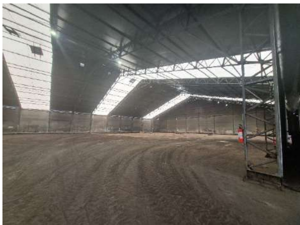
Figura 2-1 – Galpão de Estocagem 02 – vista interior
