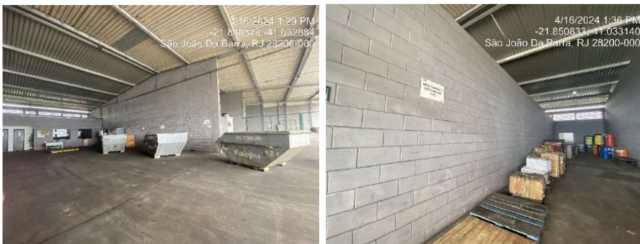
Figura 4-14 – Área de armazenamento temporário de resíduos TMULT
