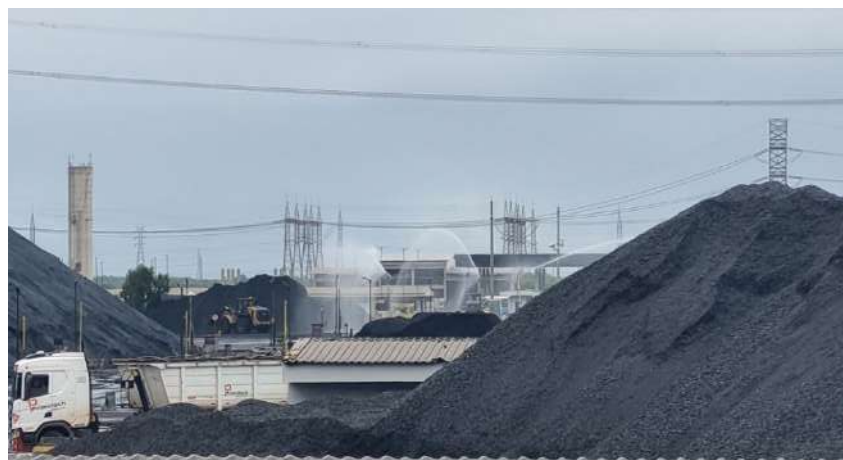
Figura 4-7 – Funcionamento do sistema de aspersão do pátio de estocagem de granéis sólidos
