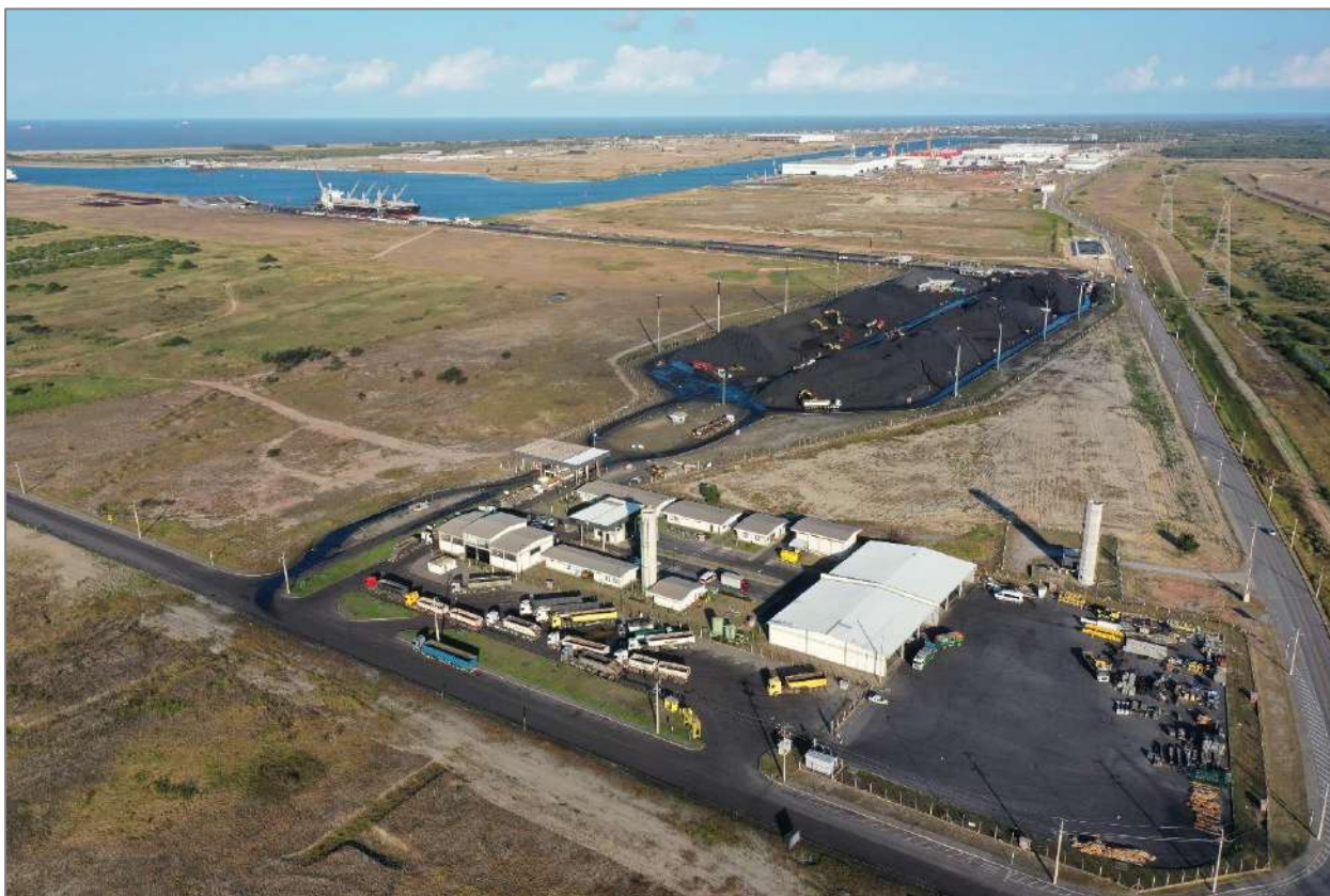
Figura 2 – Foto Aérea das Áreas Administrativas e Operacionais do T-MULT
