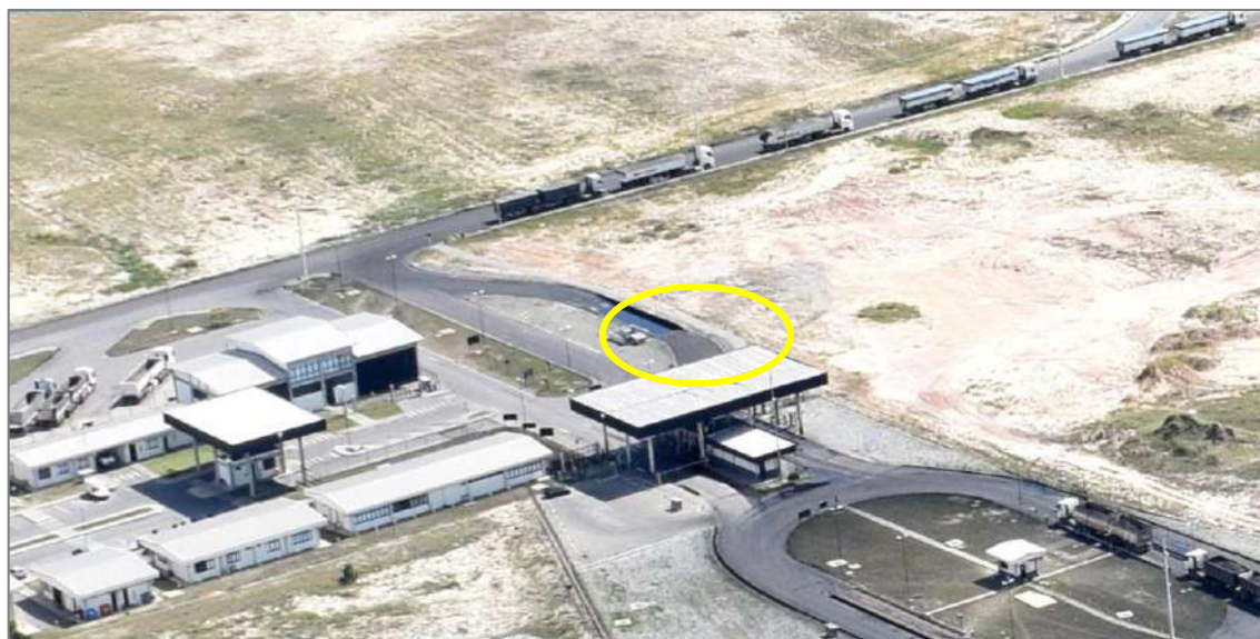
Figura 5 – Lava-rodas instalado no T-MULT
