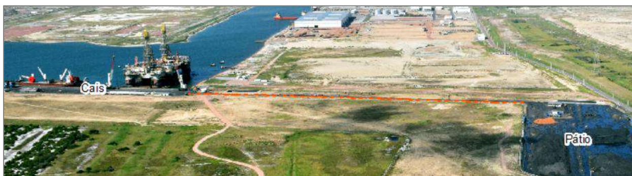
Figura 7 – Via Pavimentada entre o Pátio de Granéis e o Cais destacada na Linha Laranja
