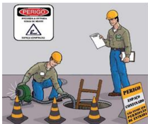
Ventilação e Sinalização (Fundacentro, 2009)
